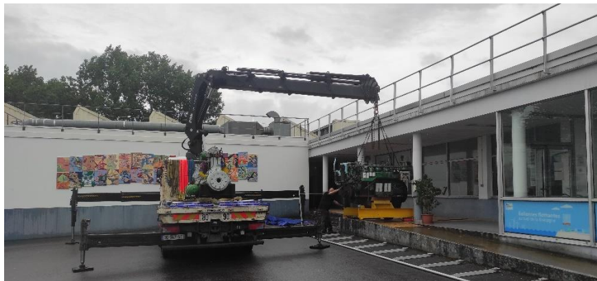
Manutention et installation du nouveau moteur POYAUD V12
