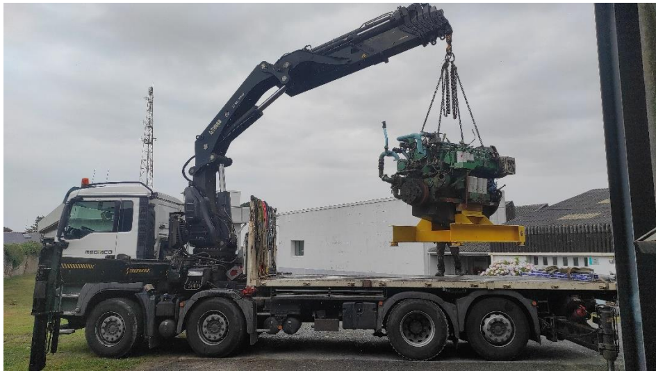
Manutention et installation du nouveau moteur POYAUD V12
