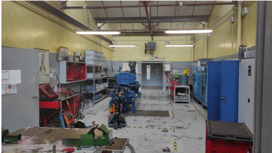
Déplacement des anciens moteurs de l'atelier
